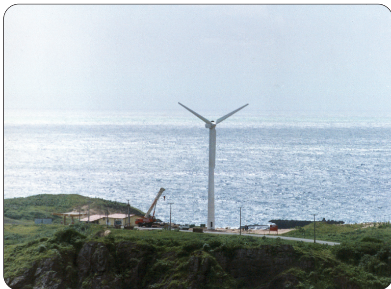
Turbina eólica instalada na Ilha de Fernando de Noronha/PE, pertencente ao CBEE/UFPE, com capacidade para gerar 275 kW.
